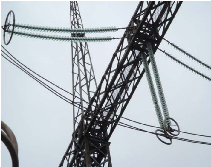
Рисунок 1.3 – Гірлянди підвісних тарілчастих ізоляторів
