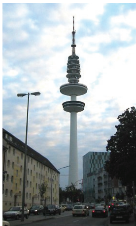
Рис. 1.9. Комунікаційна башта у м. Гамбург (збудована 1968 р.) : висота – 272 м, діаметр основи – 41 м, конструктор – Леонард Фрітц, архітектор – Юрген Слейч [20]
