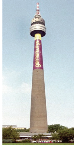
Рис. 1.12. Телебашта у м. Дортмунд (збудована 1959 р.) : висота – 219,6 м, діаметр – 14 м [27]
