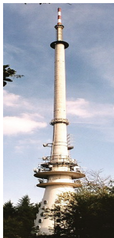
Рис. 1.10. Телебашта у м. Доннерсберг (збудована 1962 р.) : висота – 205 м, діаметр – 5–20 м [25]
