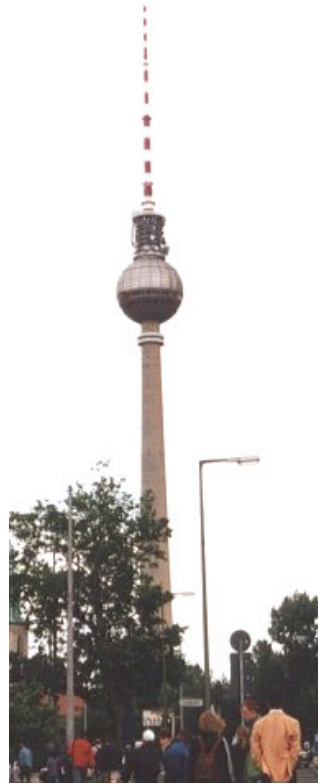
Рис. 1.6. Телебашта, м. Берлін (збудована 1966–1969 р.р.): висота – 368,03 м, діаметр основи – 32 м, гол. конструктор – Герхард Фрост, архітектор – Герман Хансельман [22]
