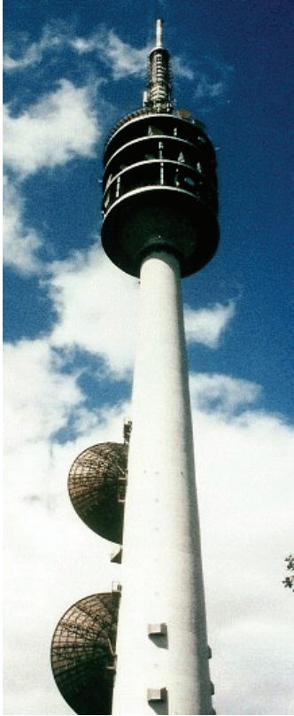
Рис. 1.5. Радіобашта, м. Берлін (збудована 1961–1963 р.р.): висота – 212 м, діаметр основи – 22,16 м, гол. конструктор – А. Г. Хотчив [21]
