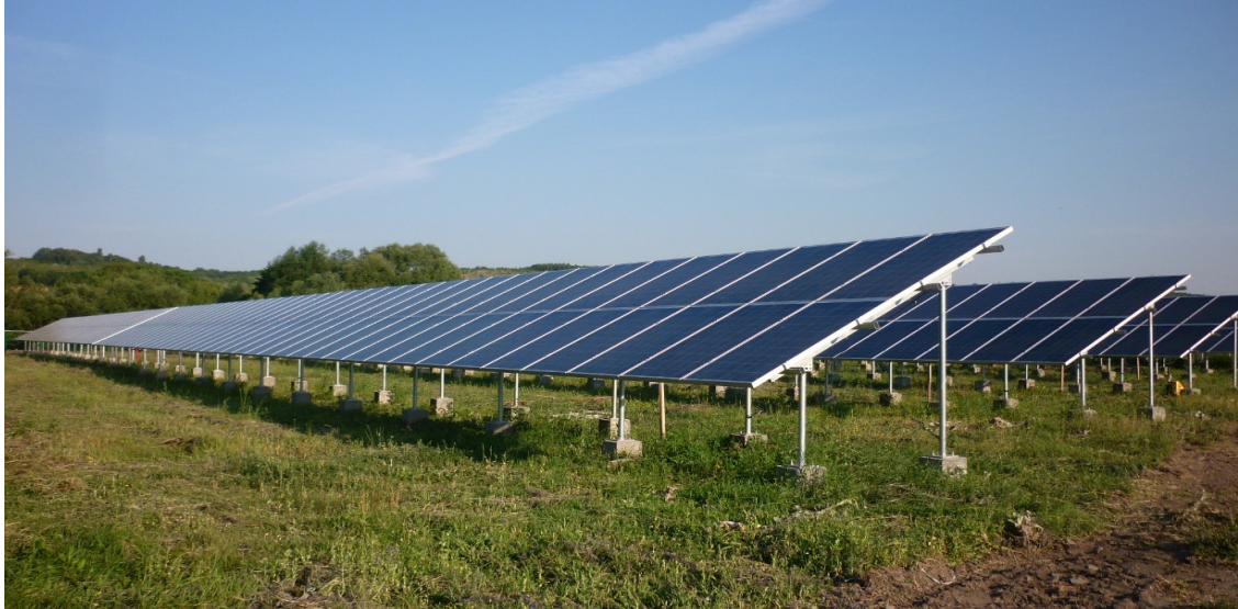
Рисунок 6.5 – Несучі конструкції для кріплення фотогальванічних модулів
