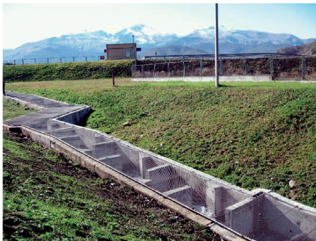
б) Сходовий рибохід Аушигерського гідровузла на річці Черек в Кабардіно-Балкарській республіці РФ.
