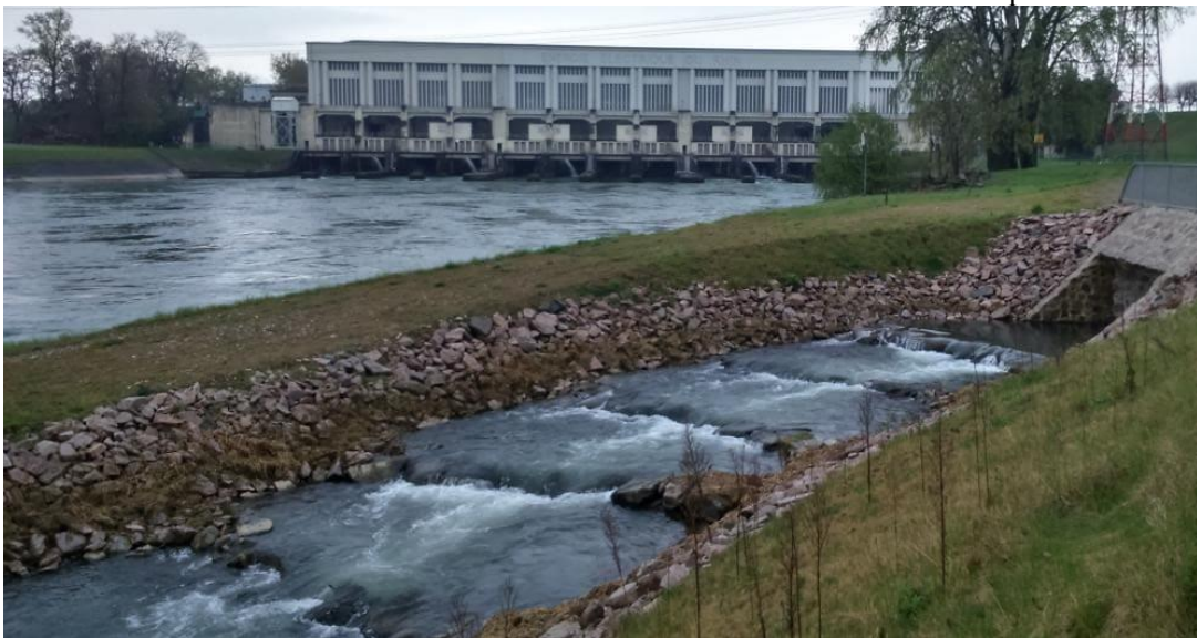
Рибохід із відновленим природним рельєфом на річці Рейн у Німеччині Рисунок 16 - Приклади рибоходів.
