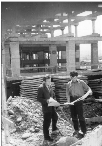
На будівельному майданчику. Праворуч Ігор Дудар – будівельний майстер
