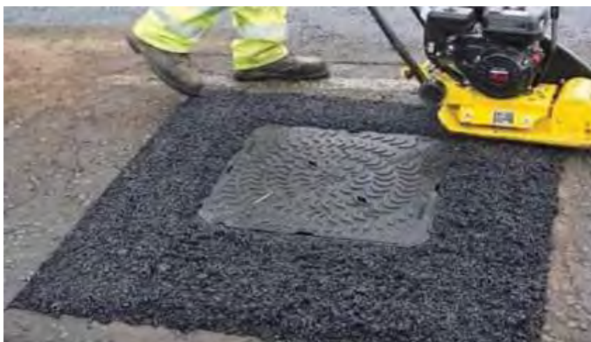
Рис. 1. Холодний асфальт - являє собою суміш мінеральних матеріалів (щебеню, піску і мінерального порошку), бітумного в'язучого і стабілізуючої добавки, яка забезпечує стійкість щебенево-мастичної суміші до розшарування.
