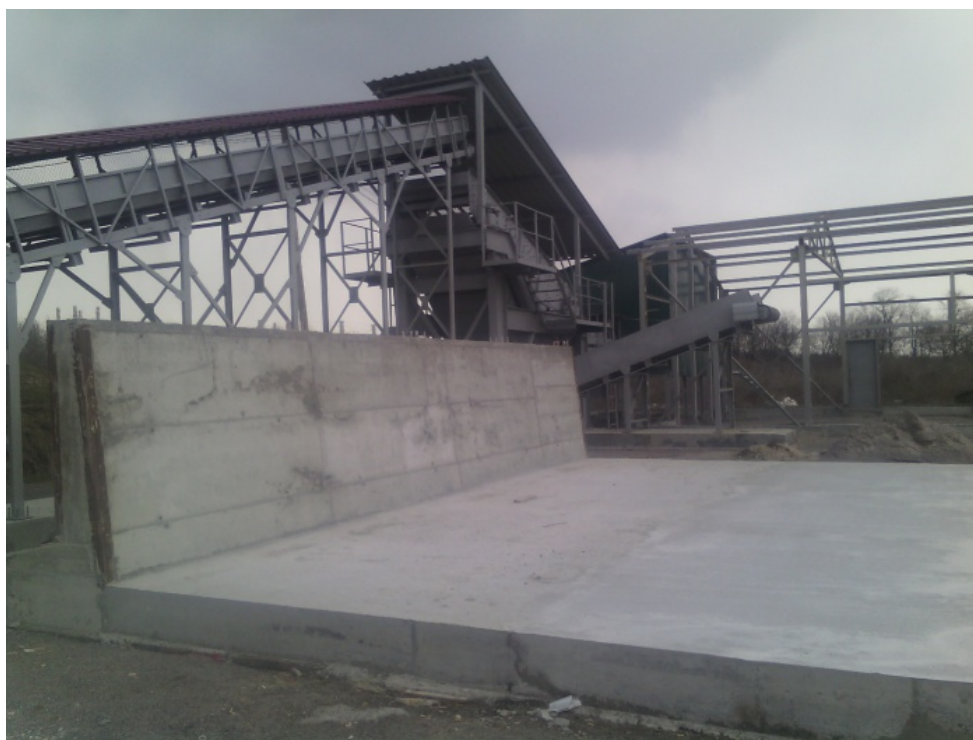
Рисунок 2.1 – Загальний вигляд сортувальної станції м. Калинівка
