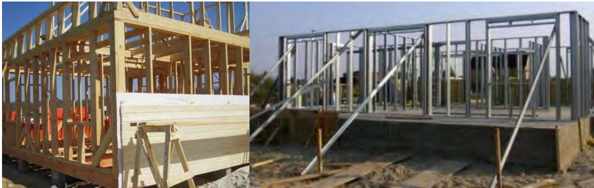
Рис. 7 – Дерев'яний і металевий каркаси каркасно-рамних будинків
