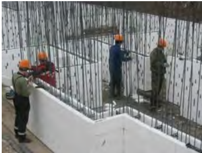
Рисунок 1- Монтаж стіни монолітного пінобетону щільністю D300 у незнімній опалубці[2].
