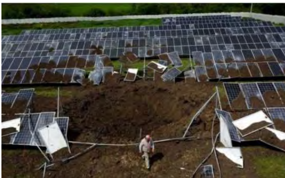
Рисунок 1 - Постраждала від ракетного обстрілу сонячна електростанція компанії Solar Generation у Харківській області – ФЕС "Мерефа" (фото Станіслава Ігнат'єва)
