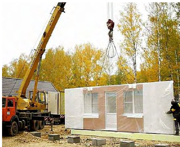
Рис. 2 – Монтаж каркасно-панельного будинку
