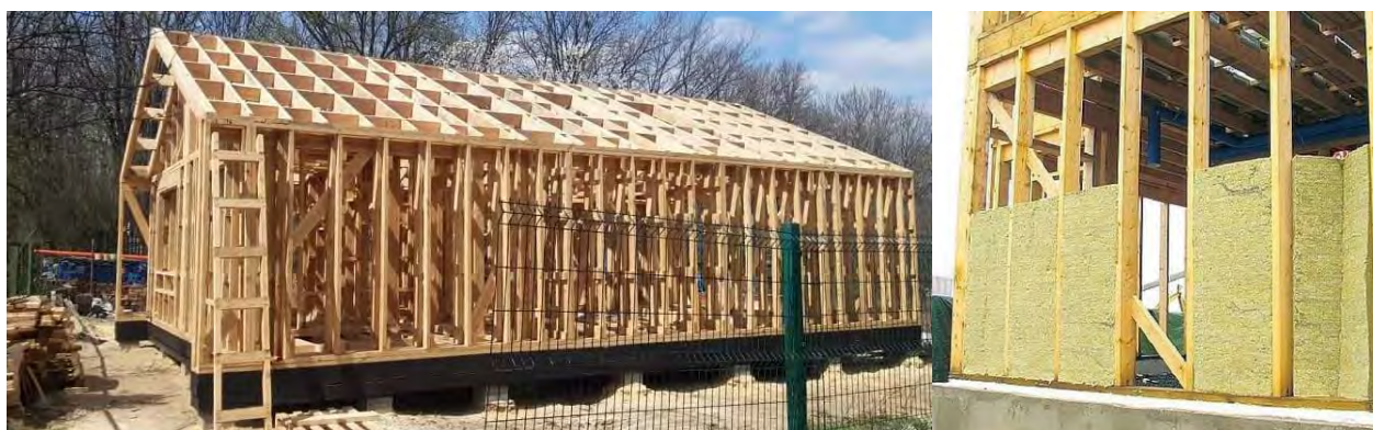
Рис. 3 – Проект каркасно-щитового житлового будинку
