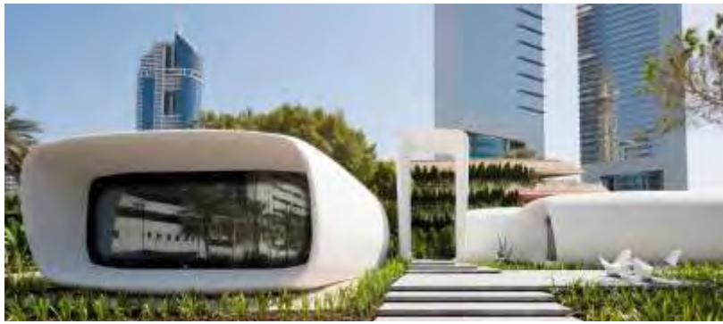
Рис. 1. Дубаї (ОАЕ) будівля має назву «Офіс майбутнього» і його площа 250 квадратних метрів. Використовувався 3D-принтер довжиною 37 метрів, шириною 12 метрів і висотою 6 метрів
