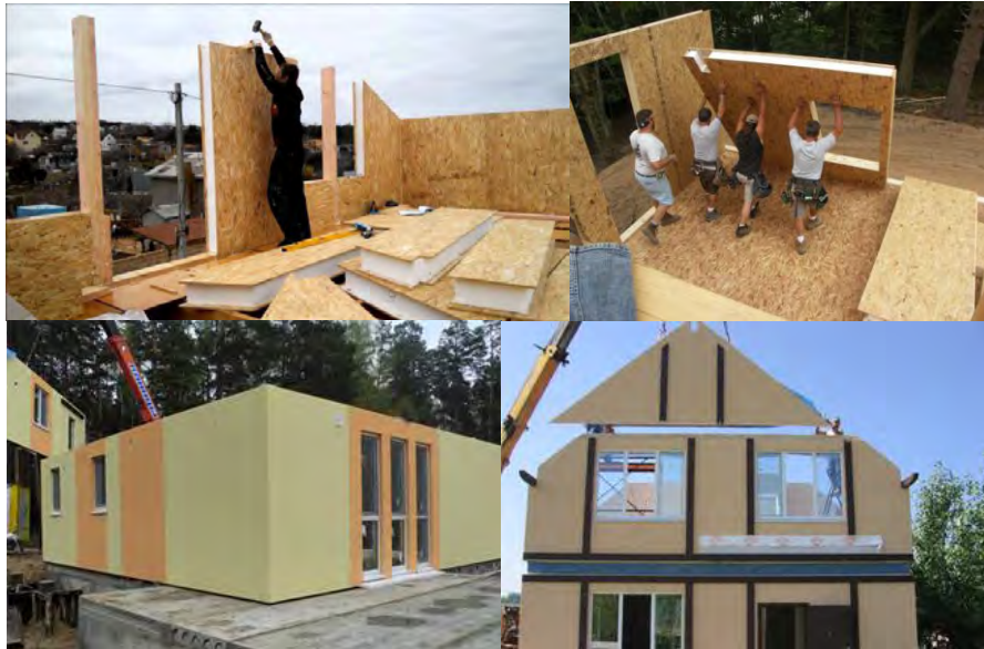
Рис. 6 – Монтаж житлового будинку із СІП-панелей
