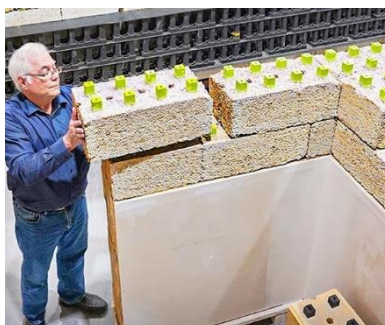
Рис.1 – Вигляд фрагменту стіни з конопляних блоків
