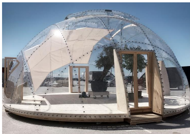
Рис. 2. Безкаркасні куполи з монолітного полікарбонату.
