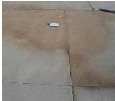
д – витіснення води з-під шару дорожнього покриття;
