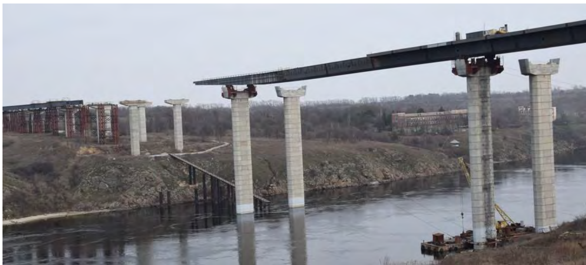
Рис. 1. Будівництво мосту методом насунання у м. Запоріжжі.
