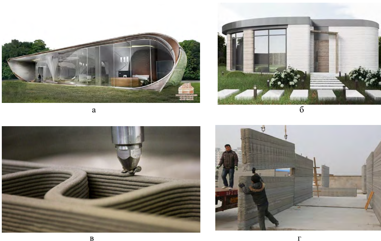
Рисунок 2 – 3D- друк будівельних об'єктів: а - б – зведення будівель; в – друкування конструкцій; г – монтаж друківаних будівельних конструкцій
