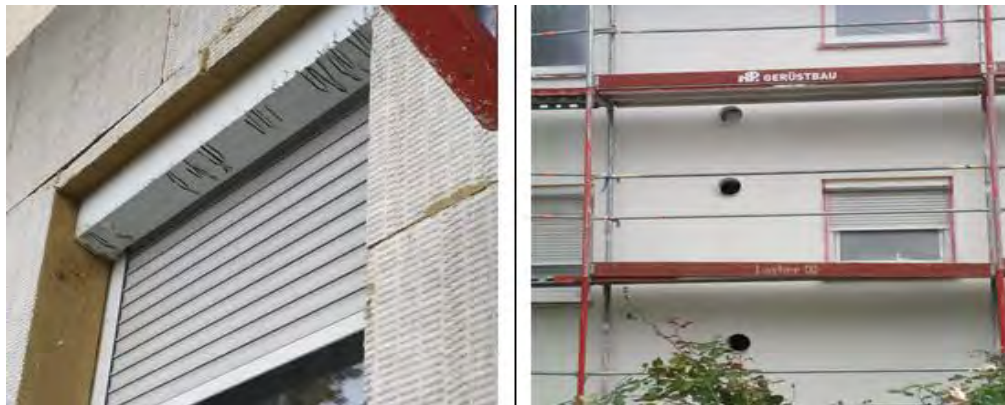
Рис. 3 Зовнішній вигляд фасаду утепленого будинку.
