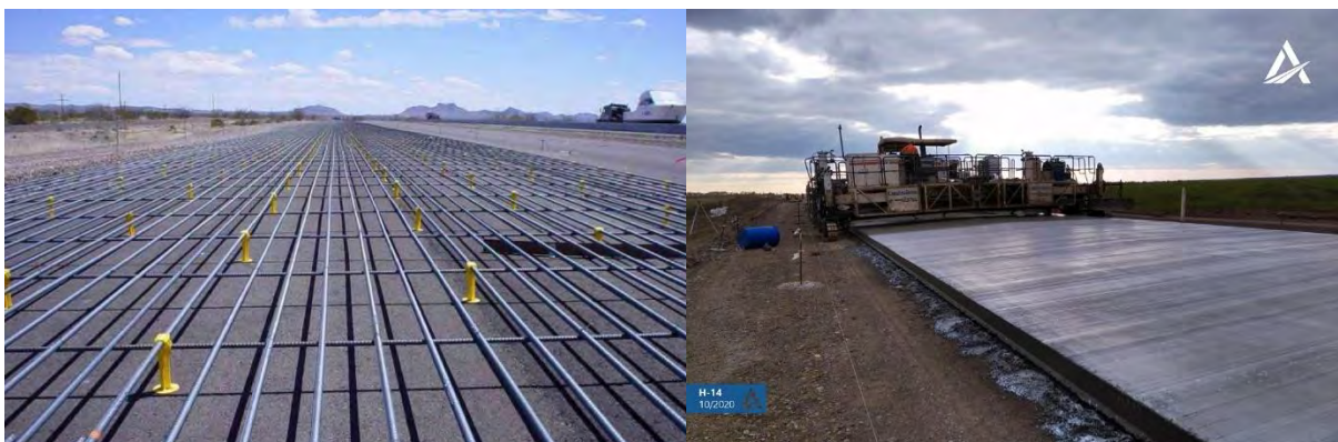
Рисунок 2 – Використання безперервно армованого бетону при будівництві доріг
