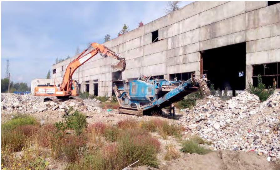
Рис. 1. Переробка демонтованих конструкцій будівлі в щебінь
