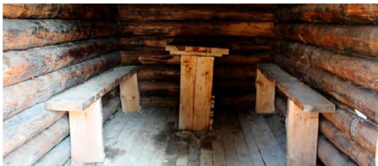
Рисунок 1 — Застосування деревини в конструкціях бліндажу
