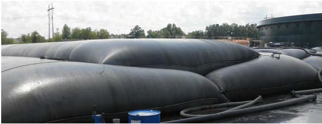
Рис. 5. Зневоднення та зберігання річкового мулу у геотубах.
