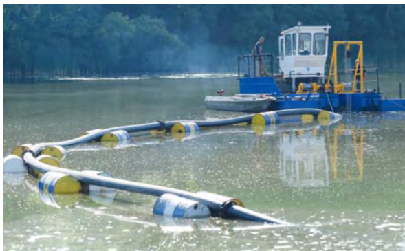
Рис. 2. Робота земснаряда в акваторії Сабаріського водосховища
