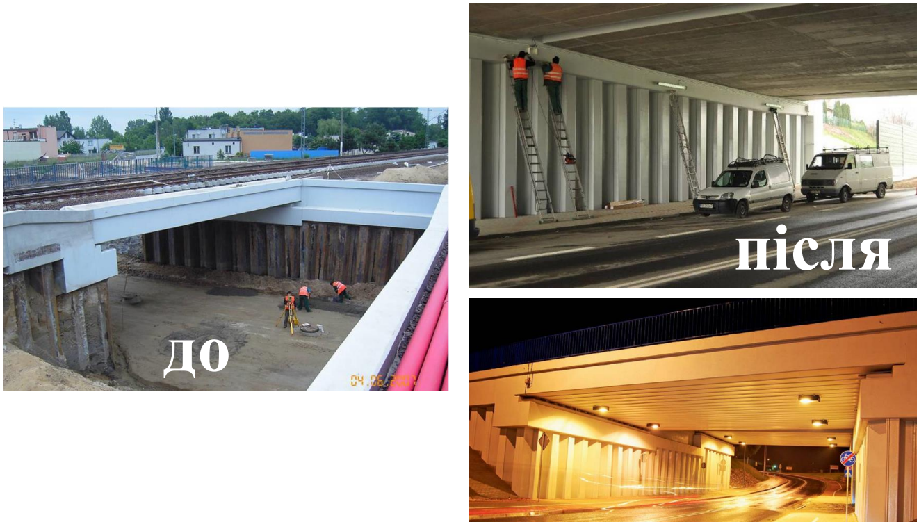
Рис. 1 – Заміна стінок огорожі ЖД виадук, Сважендз, Польща [3].
