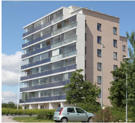
Рисунок 1 – Встановлення фотоелектричних панелей на балконах багатоповерхових будинків
