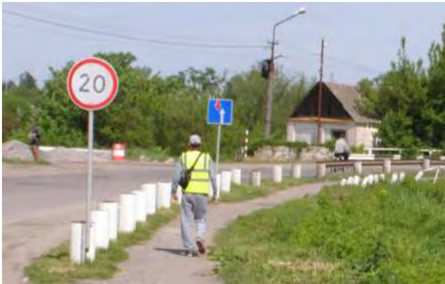
Рис. 1. Аварійна ділянка дороги Р-33 з віражем. Вимушене зниження швидкості руху автотранспорту до 20 км/год. Реверсивний рух на мостовій споруді через ненормативну кривизну віражу R < 40 м
