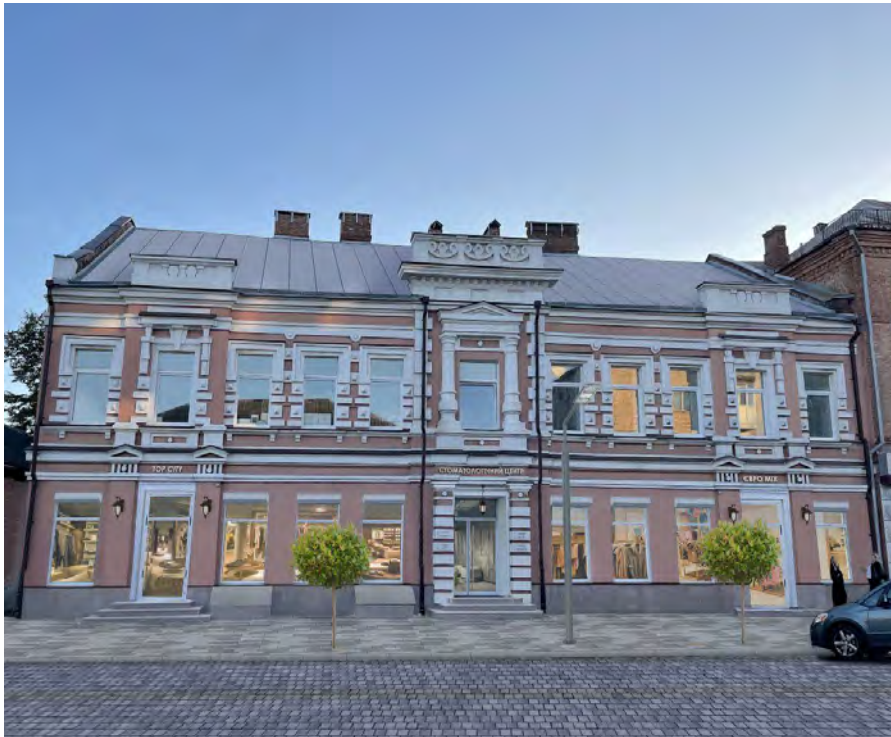
Рис.2. Фасад після очищення від візуального шуму [4]
