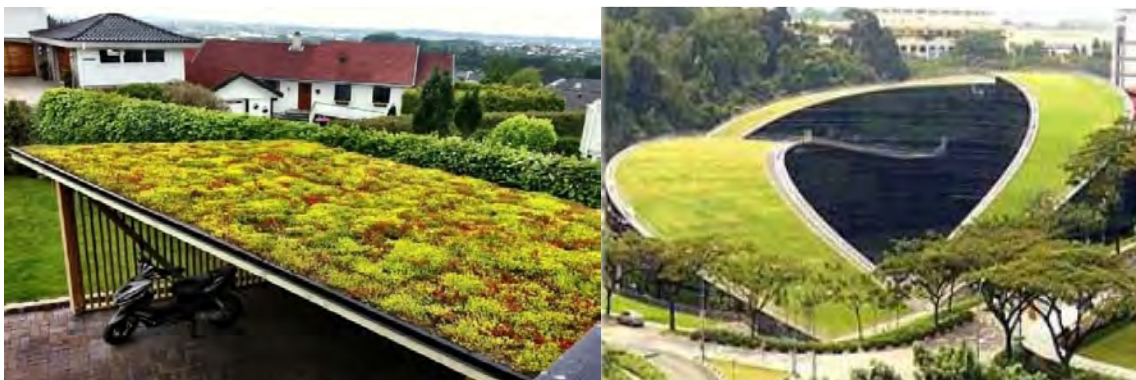
Рис. 1. Екстенсивні зелені покрівлі [7]
