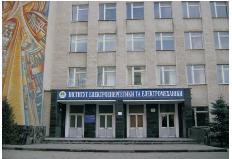
Навчально-лабораторний корпус інституту електроенергетики та електромеханіки
