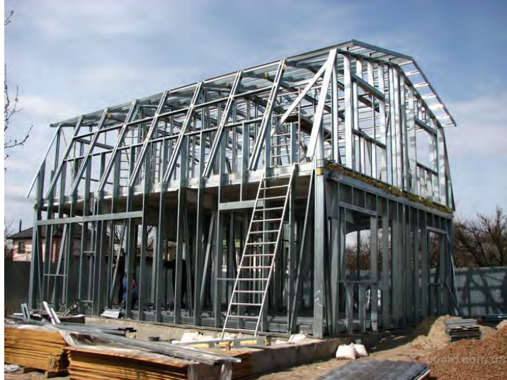
Рисунок 1 – Приклад будівництва модульного котеджу
