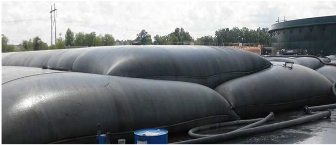
Рис. 5. Зневоднення та зберігання річкового мулу у геотубах.
