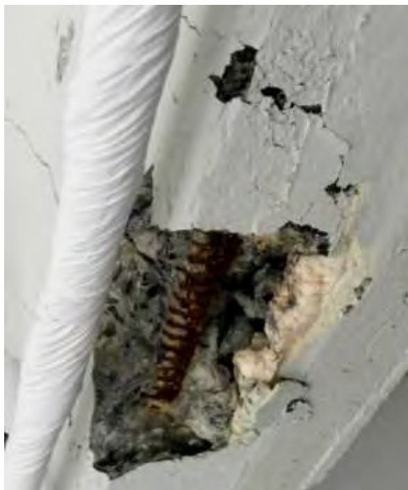
Рис. 2. Дефект повздовжніх плит покриття з різних ракурсів: руйнування бетонного каменю повздовжнього ребра з оголенням, корозією та вигинами повздовжньої арматури, численні силові вертикальні тріщини на повздовжньому ребрі.
