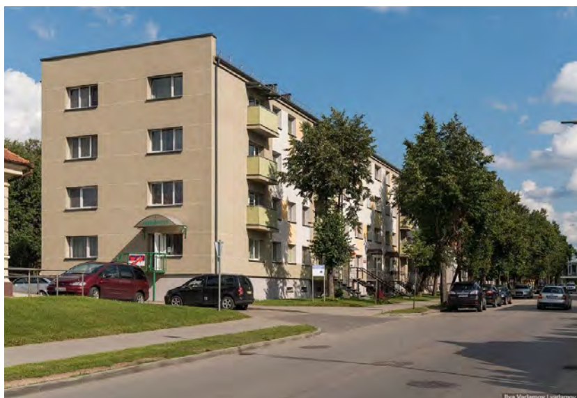
Рисунок 1. Приклад реконструкції радянської будівлі у Латвії [3]
