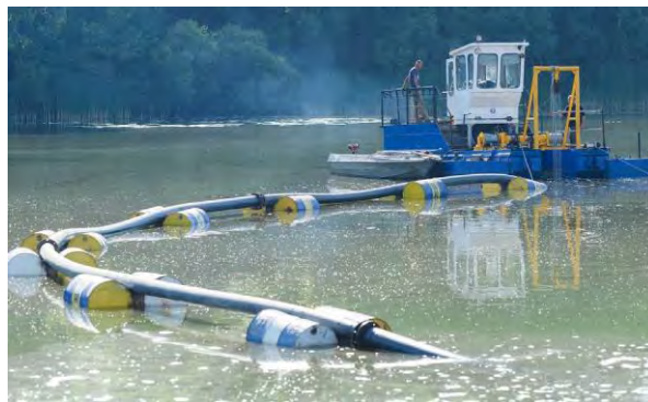
Рис. 2. Робота земснаряда в акваторії Сабарівського водосховища
