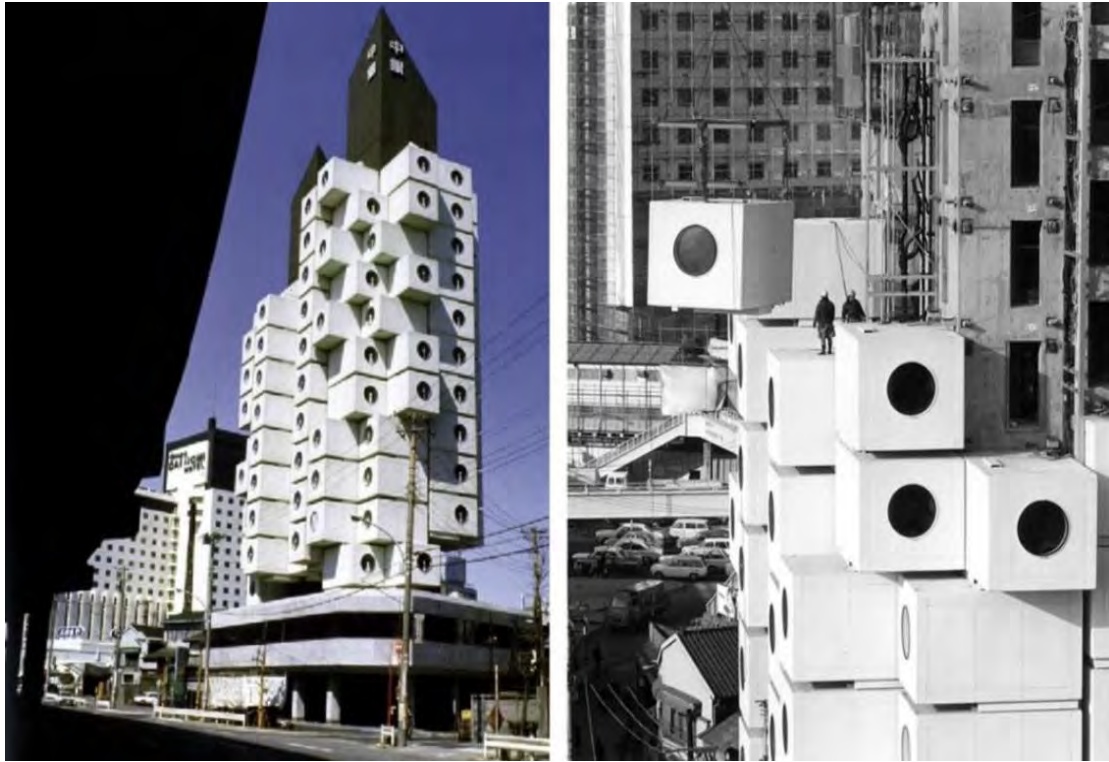
Рисунок 3 – Вежа Накагін, побудована та в процесі монтажу «капсул», Японія
