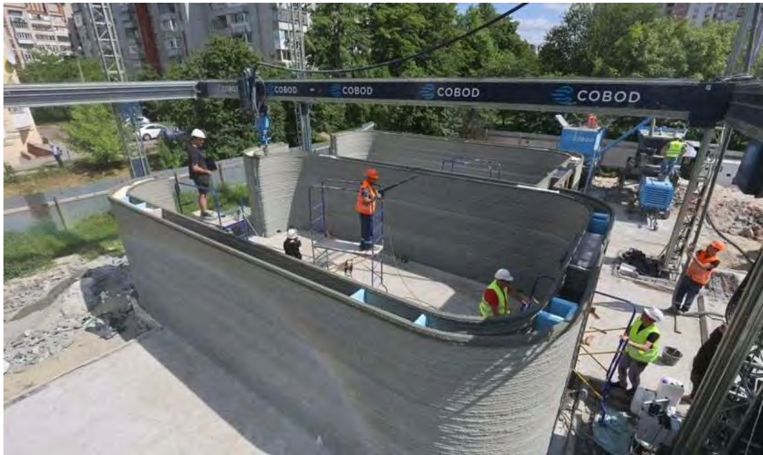
Рис.1 будівництво школи № 23 у Львові за 3D-технологією [3]
