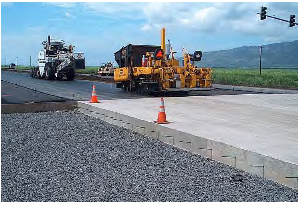
Рис. 1. Будівництво цементобетонної дороги за допомогою спеціалізованої техніки
