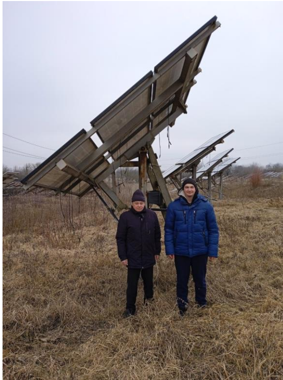
Рисунок 1 – Сонячні трекери на одній з ФЕС
